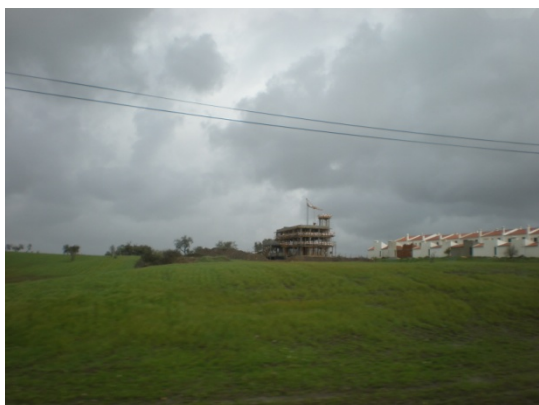
Vista para a zona nova de Silveiras com a Igreja em construção
